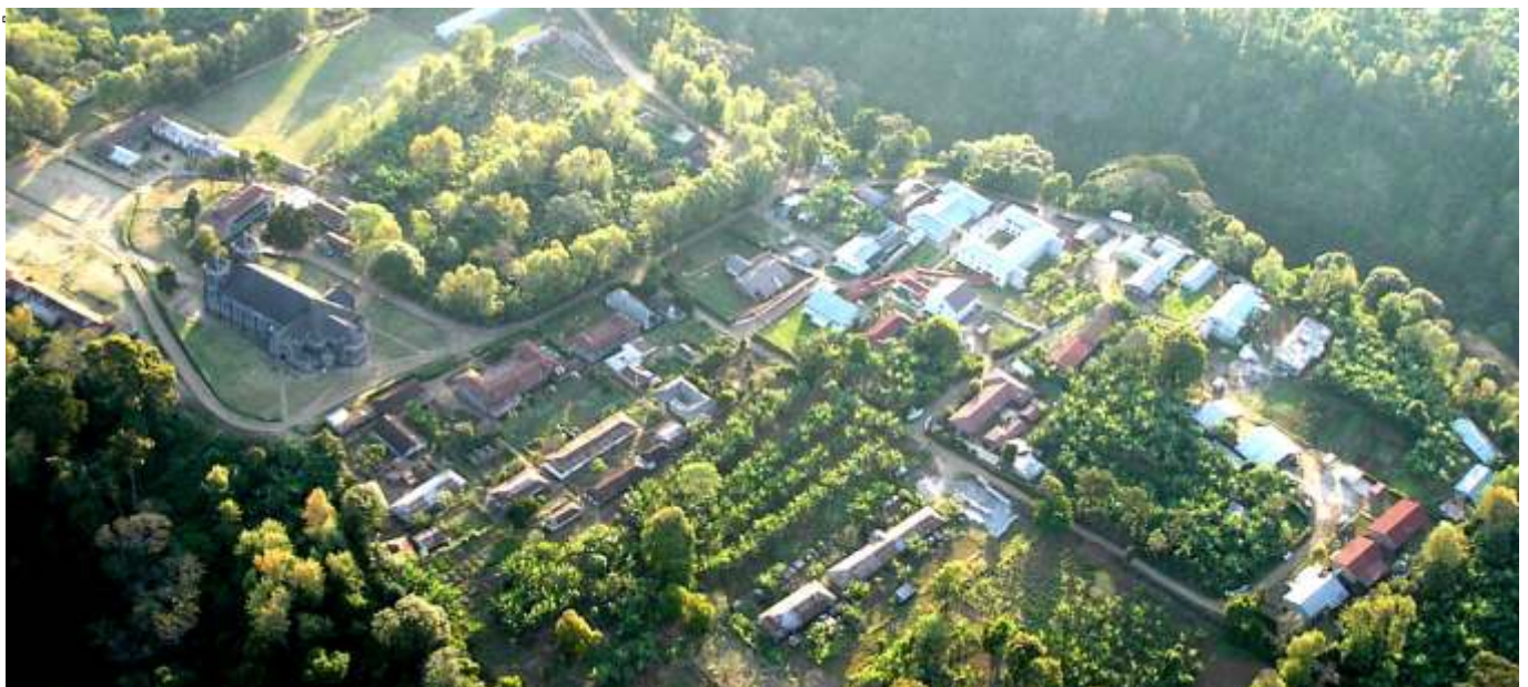
Kibosho Hospital und Pfarrkirche. Die neue Augenstation steht neben dem Hauptgebäude.
