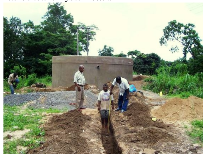
Verlegung der Wasserleitung am kleineren Tank I
