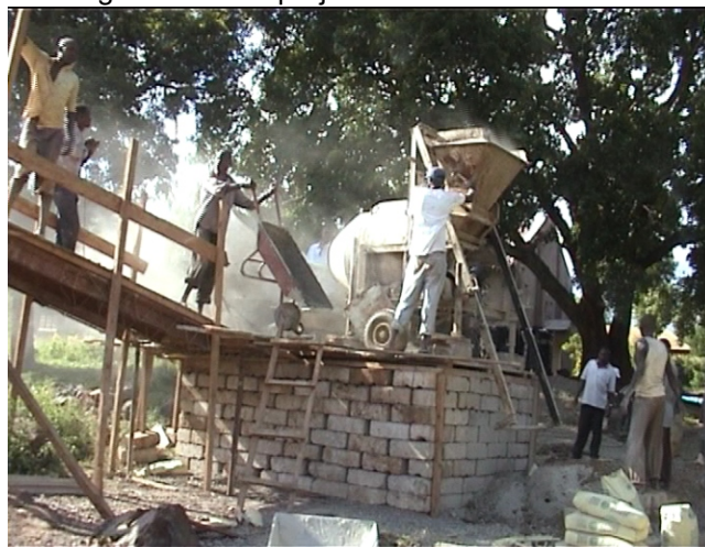
Betonierarbeiten am großen Wassertank
